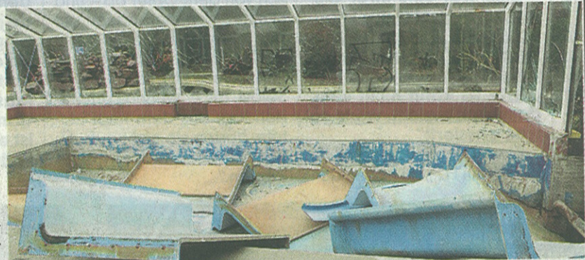
Die frühere Rutsche wird derzeit in ihre Einzelteile zerlegt und abtransportiert (oben). Seit 2003 ist Ebbe in der Grottenlandschaft (unten)
